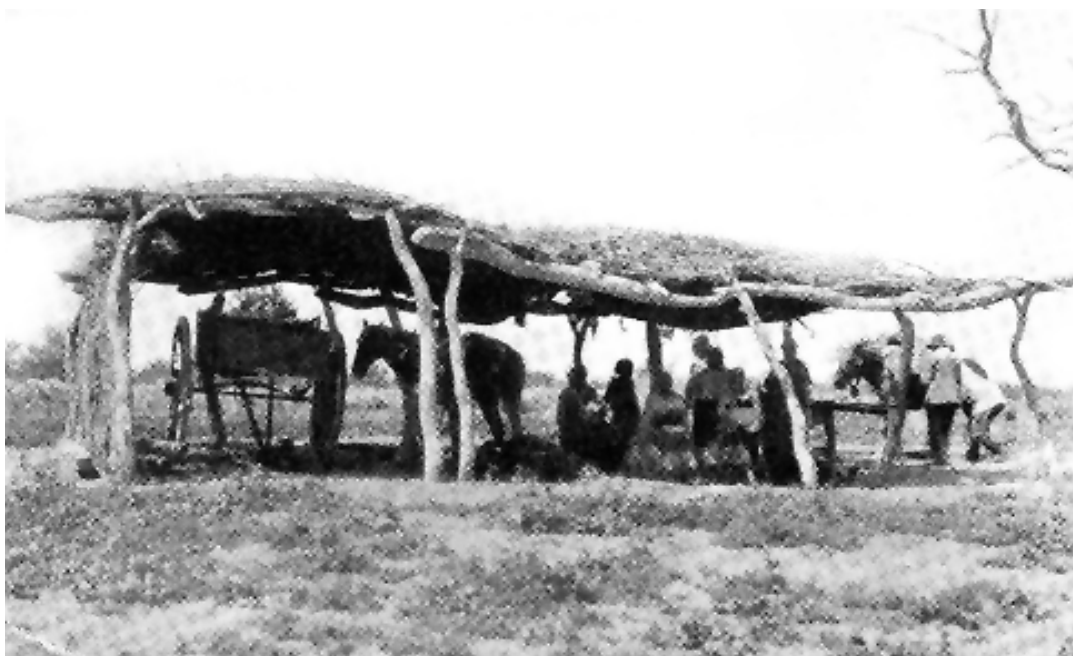
La “entramada” o “ramada” - tipo clásico de construcciones auxiliares de la vivienda
